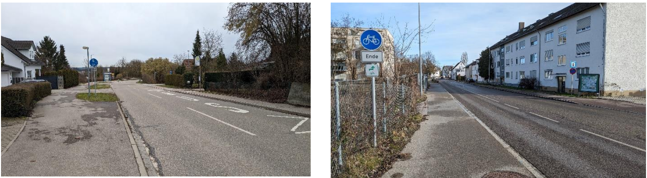
Abbildung 40: fehlende Querungshilfe Aufheimer / Uffholtzer Straße (links); fehlende Querungshilfe am Ortseingang Senden, Hauptstraße (rechts)
