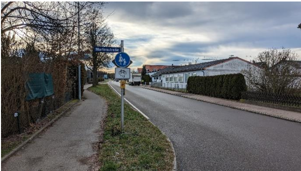
Abbildung 32: Entspricht nicht den Anforderungen an qualitativ hochwertige Radverkehrsanlagen: Die Führung über einen Gehweg, Radfahrer frei (straßenbegleitend)
