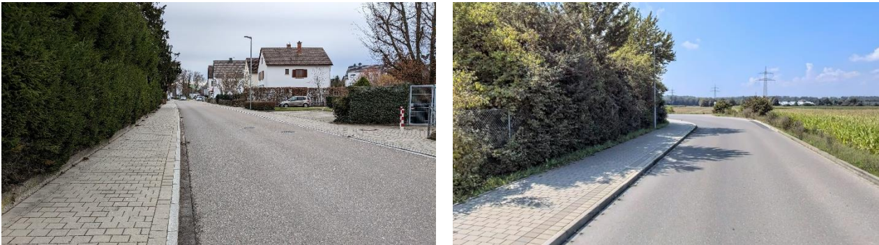
Abbildung 39: Hecke ragt stark auf einseitigen, benutzungspflichtigen Geh- und Radweg (links) und Bewuchs im Sichtfeld, sodass entgegenkommende Radfahrer nicht gesehen werden können (rechts)
