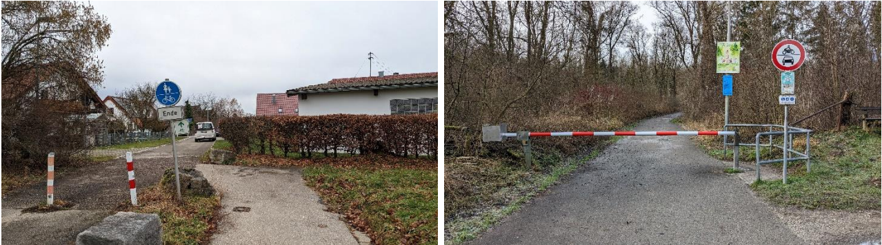
Abbildung 37: Gefahrenpunkte auf der Strecke: Poller (links) und Schranke (rechts), wobei der Durchgang eine unzureichende Breite aufweist
