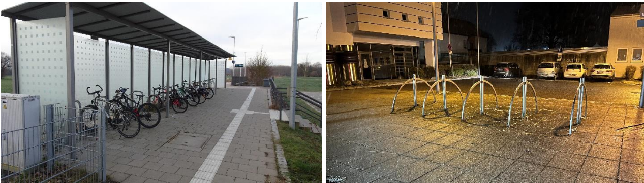
Abbildung 53: Überdachte Anlage mit Vorderradhaltern (links) und hochwertige Abstellanlage mit Anlehnbügel in der Sendener Innenstadt (rechts)
