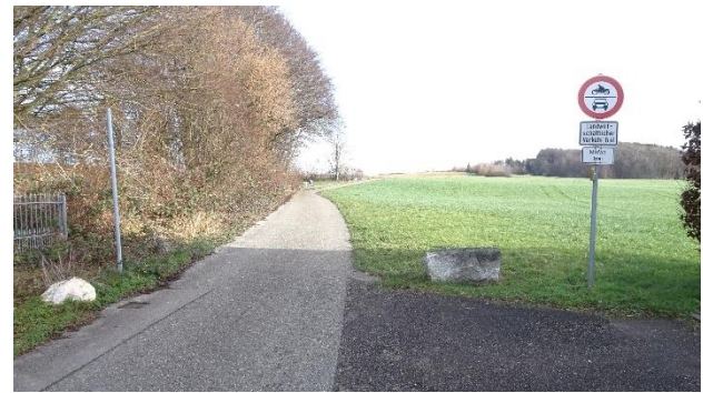
Abbildung 29: Gesicherte Radverkehrsführung: Mischverkehr innerhalb einer Tempo 30-Zone (links) und Führung auf einem Kfz-freien Weg (rechts)
