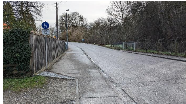
Abbildung 32: Entspricht nicht den Anforderungen an qualitativ hochwertige Radverkehrsanlagen: Die Führung über einen Gehweg, Radfahrer frei (straßenbegleitend)
