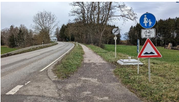
Abbildung 30: Ungesicherte Abschnitte laut Definition: Für den Radverkehr freigegebener Gehweg bei Tempo 100 (links) und Mischverkehr bei Tempo 50 innerorts (rechts)
