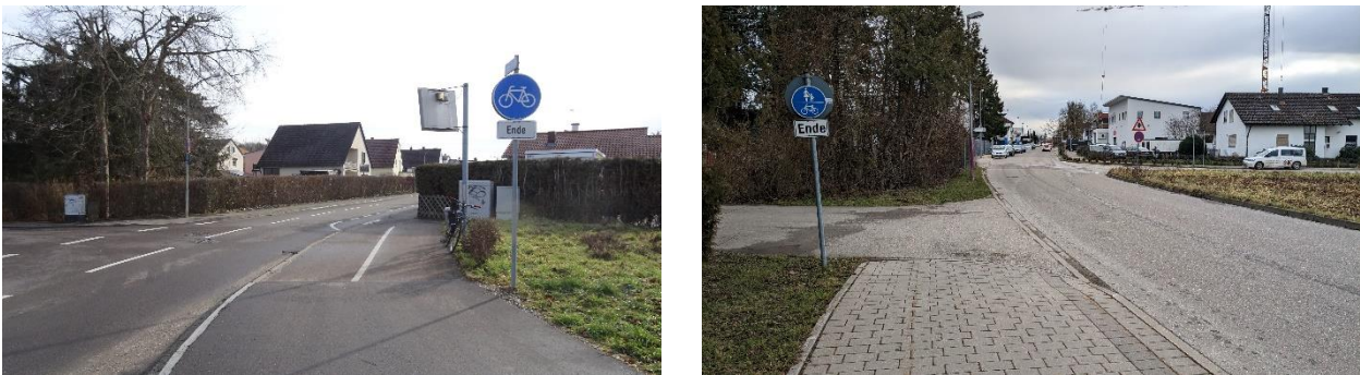
Abbildung 38: fehlende Überleitung zwischen baulichem Radweg und Führung auf der Fahrbahn (Lange Straße, der bauliche Radweg ist in beide Richtungen benutzungspflichtig; links) und fehlende Überleitung ohne Rückenschutz an der Alemannenstraße (rechts)
